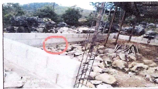
Foto 4: Rehabilitacion de una pila de concreto
