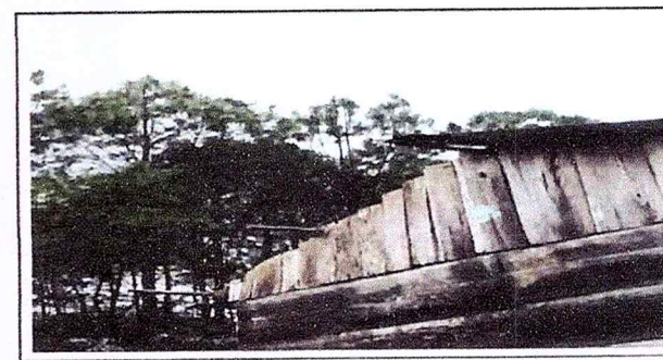
Foto 6: Sustitucion de lamina acanalado por laminas troqueadas calibre 26
