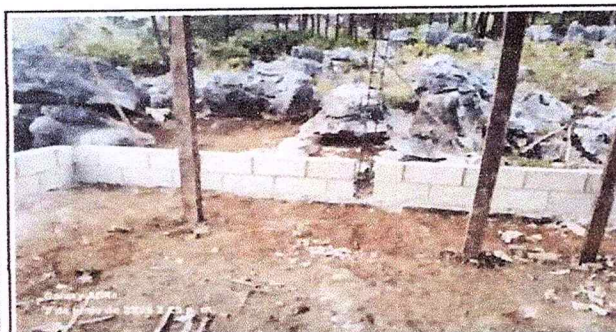
Foto 3: Rehabilitacion de entortado
