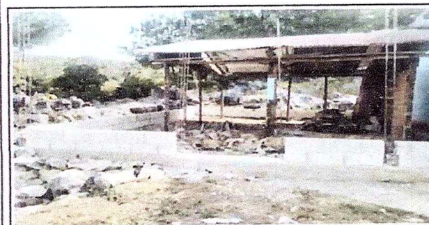
Foto 5: Culminacion de fundicion de columna y pegado de block
